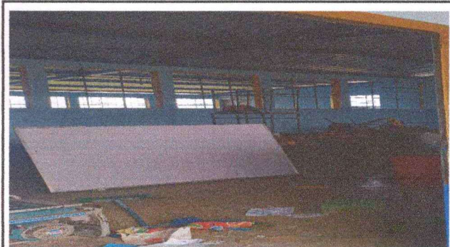
Foto 2. Se procede a dar el mantenimiento a la estructura portante y balcones del modulo 2
