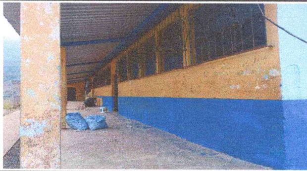
Foto 1. Se da el mantenimiento a la estructura portante, se procede a pintar las paredes en el modulo 2.
