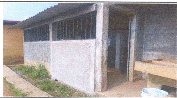
Foto 5: Proceso de repellado y cernido, en paredes del modulo de baño de niñas.
