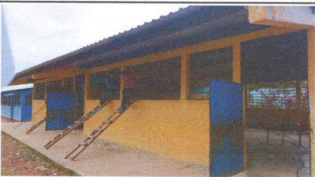
Foto 3: Se procede a la preparacion de ventanales para el pintado y colocacion de vidrios nuevos en el modulo 3.
