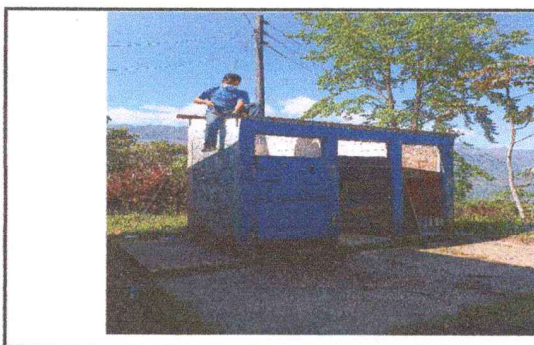
Foto 6: Se procede al destechado de la cubierta delamina de las litrenas, previo a otros trabajos a realizar.
