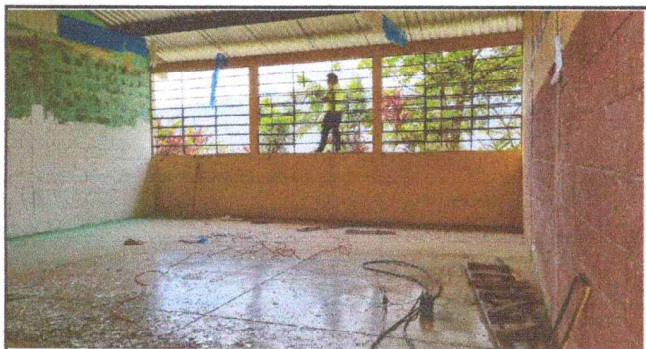
Foto 4: Se observa la mitad de la pared ya con impermeabilizante colocado y mantenimiento de area de ventanales, para posteriormente colocar vidrios en el modulo 3.
